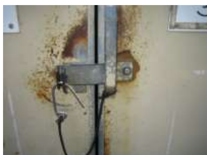
写真 2. 物置の扉とレールを強化した例 (左：対策前、右：対策後)
