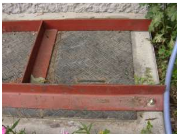
写真2. L字鋼をボルト止め
