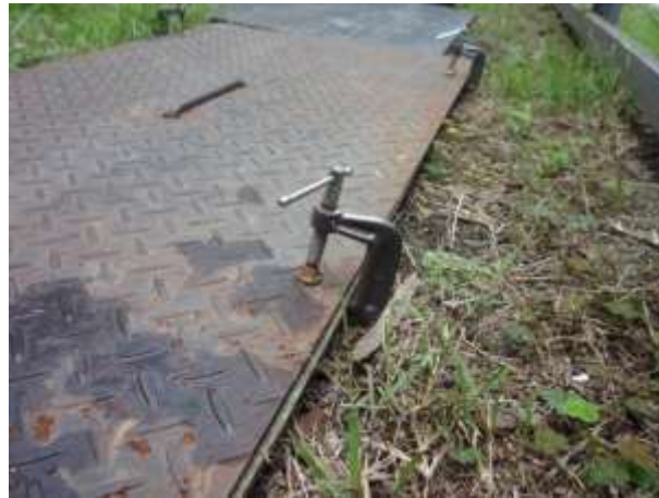
写真1. 蓋と本体を小型の万力で固定
